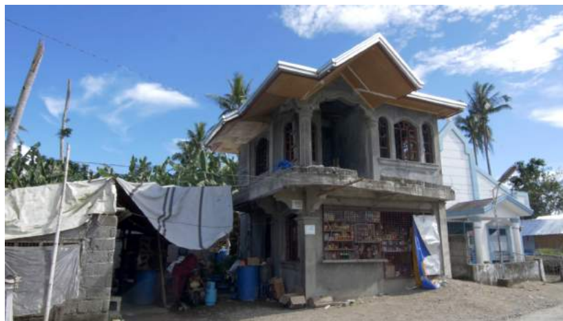
2013年11月の大型台風ハイヤンで建物の9割以上が全・半壊 1年経ってもなお、布やビニールシートで雨風を凌ぐ住宅多数
